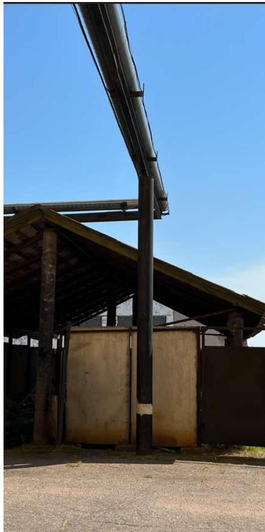
1 pav. Esamos estakados konstrukcijos.
